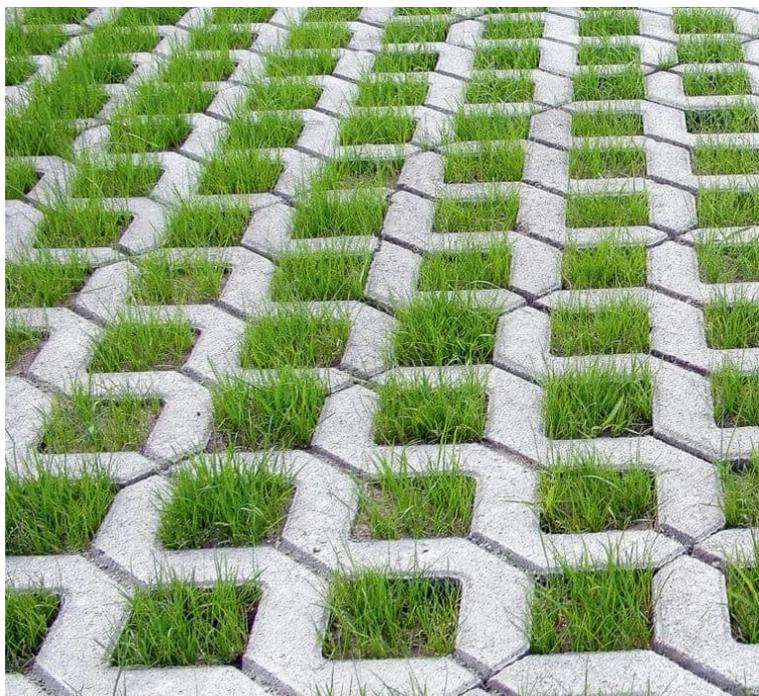
Figure 36. Openwork plate (source: [https://betongyepacs.hu/beton-gyepacs\\_ar.php](https://betongyepacs.hu/beton-gyepacs_ar.php))
