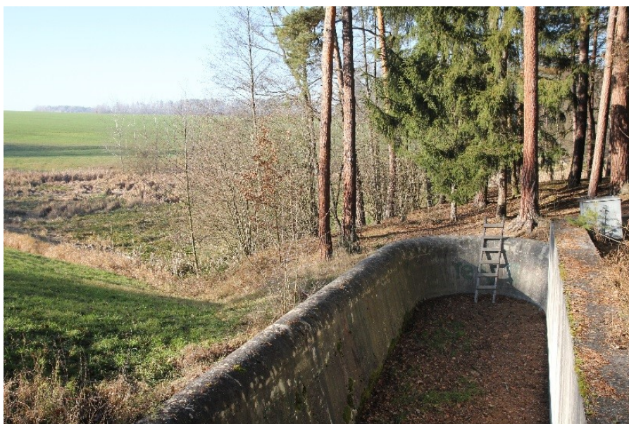
Přepad u retenční nádrže v roce 2019
