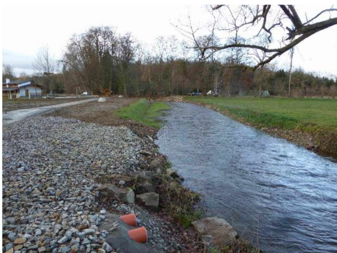
Stav po realizaci (obtokový kanál):
