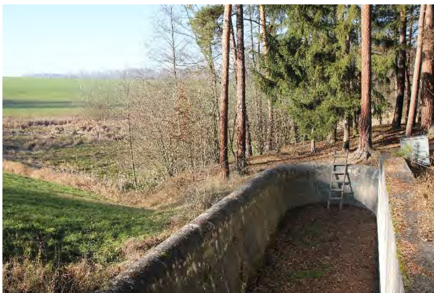
Přepad u retenční nádrže v roce 2019
