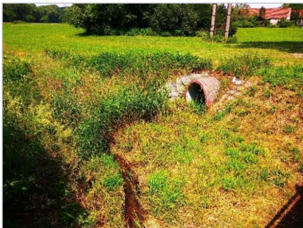
Odlehčovací potrubí u propustku (Zdroj: Krajský úřad Jihočeského kraje, oddělení územního plánování)
