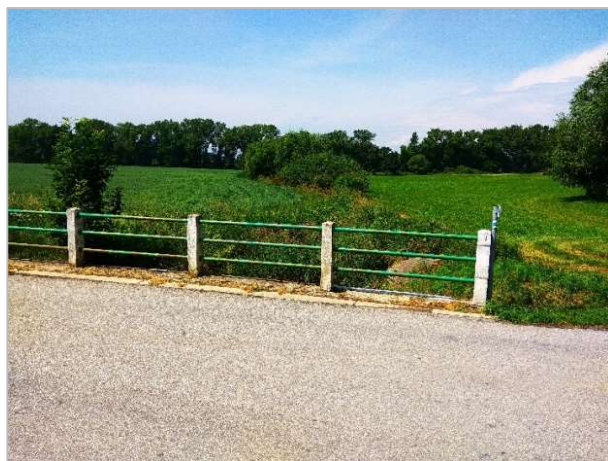
Pohled od propustku ve směru toku Dehtářského potoka (Zdroj: Krajský úřad Jihočeského kraje, oddělení územního plánování)
