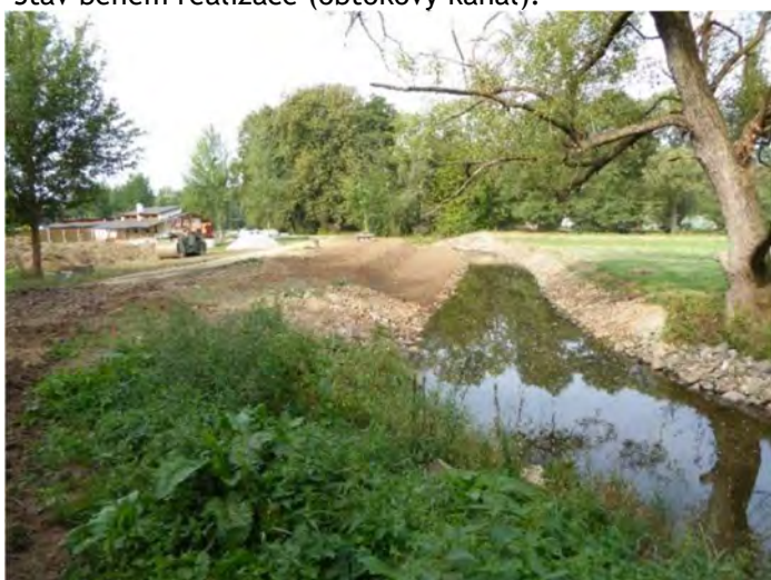
Stav během realizace (obtokový kanál):
