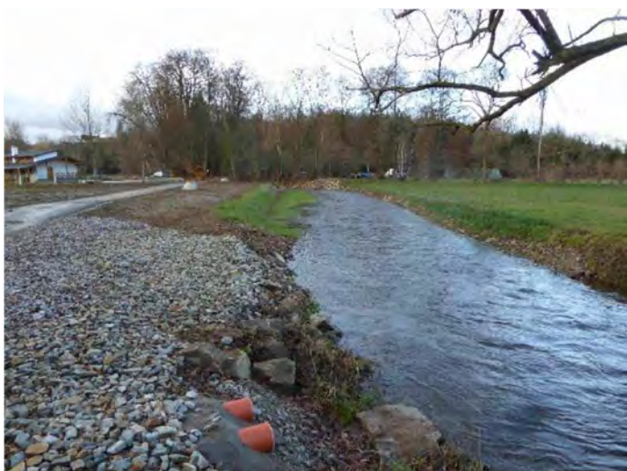
Stav po realizaci (obtokový kanál):
