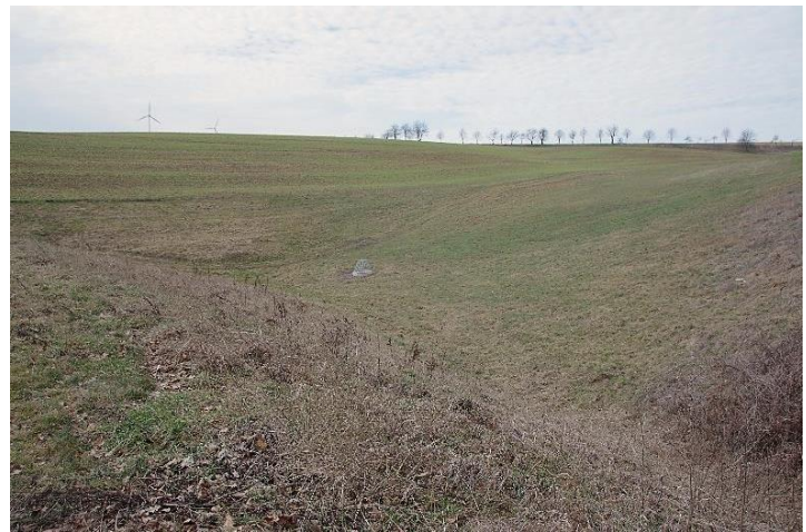
Blick auf das Retentionsbecken mit Bodenauslass.
