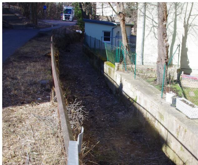
Ungenutztes Mühlgrabensystem, das bei einem vergangenen Starkregenereignis die Rückhaltekapazität erhöhte.
