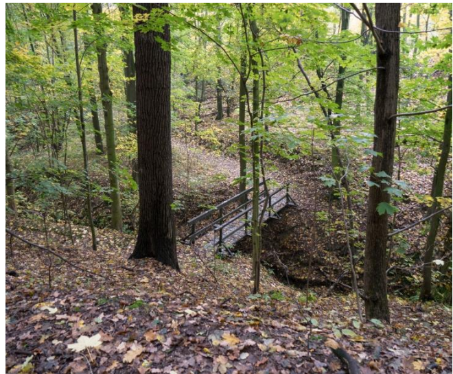
Wiederhergestellte Brücke in angepasster Bauweise im Stadtpark nach dem Starkregenereignis. Quelle: P. Voigt
