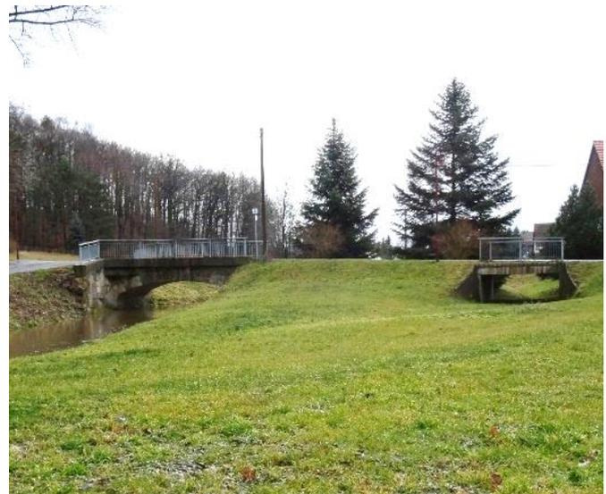
Durchlässe, wie der rechts auf dem Bild befindliche, verbessern die Abflussverhältnisse dauerhaft nur, wenn durch Wartung ihre Funktionsfähigkeit aufrechterhalten wird. Dies kann sehr aufwändig sein. Auf solche Leistungen zum Hochwasserschutz zu verweisen, kommt einer Gemeindeverwaltung jedoch eigentlich nicht in den Sinn und wird entsprechend von den Anliegern auch nicht anerkannt. Geschickt eingesetzte Informationsschilder können die Funktionsweise von Anlagen erklären.
