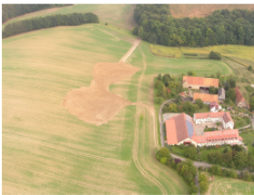
Oktober 2012 Verwallung fertiggestellt
